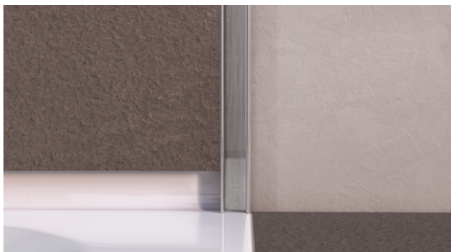
U-Profil wird von den Fliesen eingefasst
